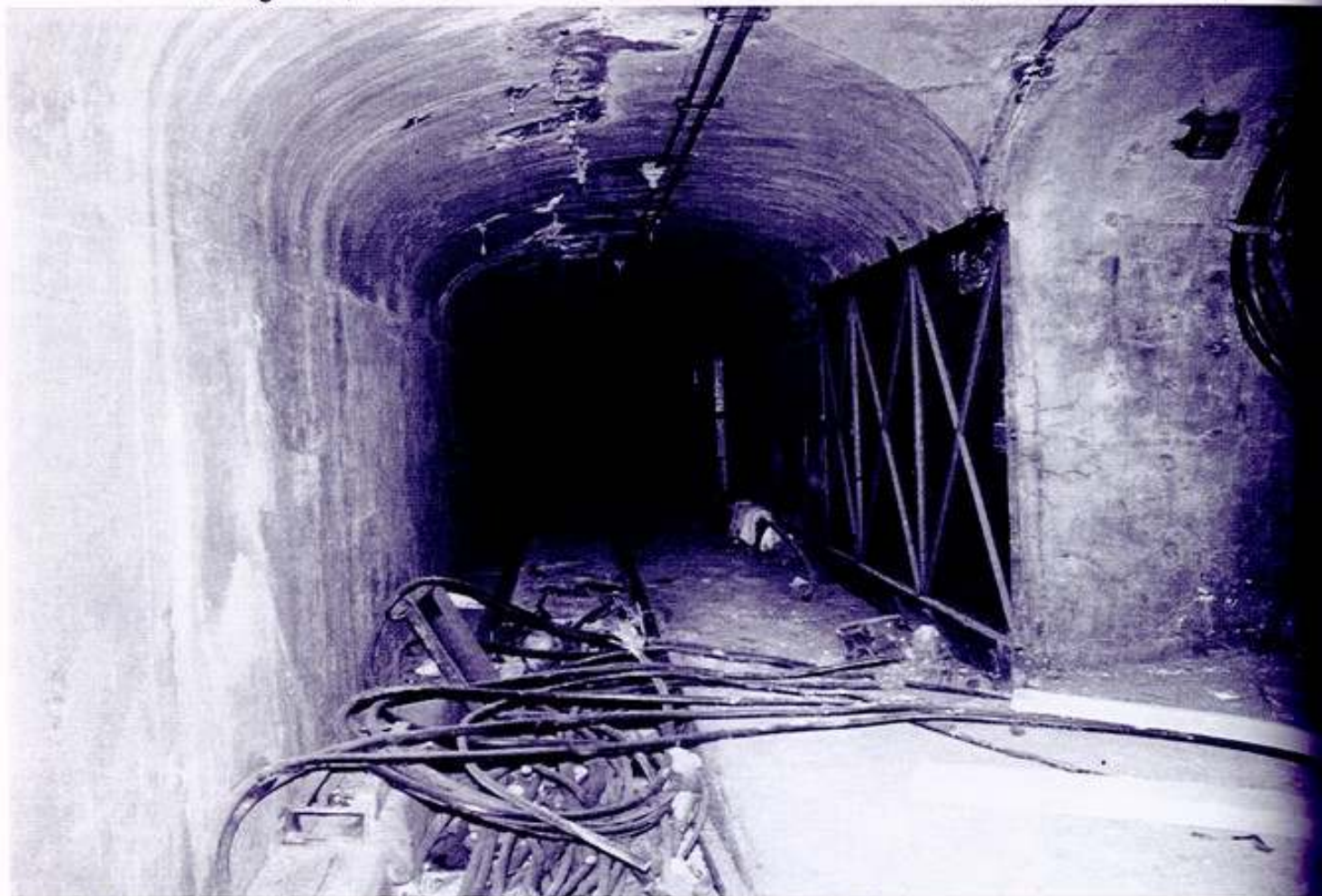
Fig. 4 : La voie et le quai de chargement de la "Ligne des Finances", tel qu'il subsistait encore en 1990 avant les travaux de Météor.
